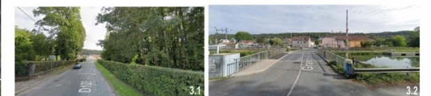
Entrée par la Grande rue via une séquence paysagère de qualité (privée) cadrant une perspective sur la commune, suivie d'une séquence très ouverte où l'espace est marqué par les franchissements de la voie ferrée et du canal du Rhône au Rhin. Cette rue constitue l'axe d'entrée historique de la ville qui pourrait être mieux valorisé.
